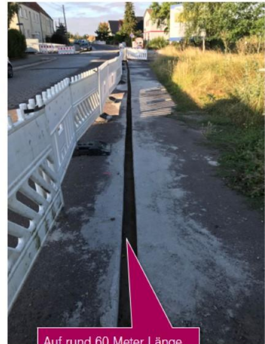
Auf rund 60 Meter Länge Asphalt, darunter Pflaster
